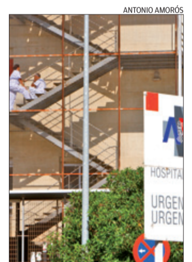
Escaleras externas del hospital.
